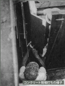
コンクリート現場打ちの様子
