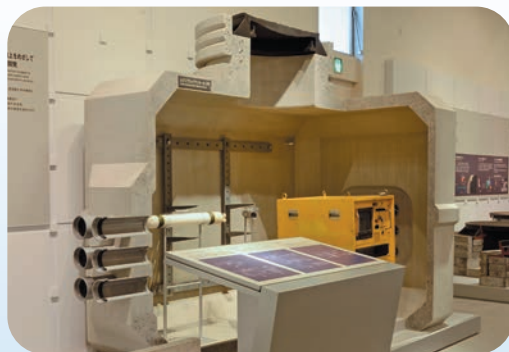
通信ケーブルを通すマンホール(模型)
